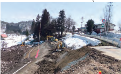
三合田地区の工事状況
