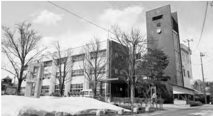
耐震改修工事を行う庁舎
