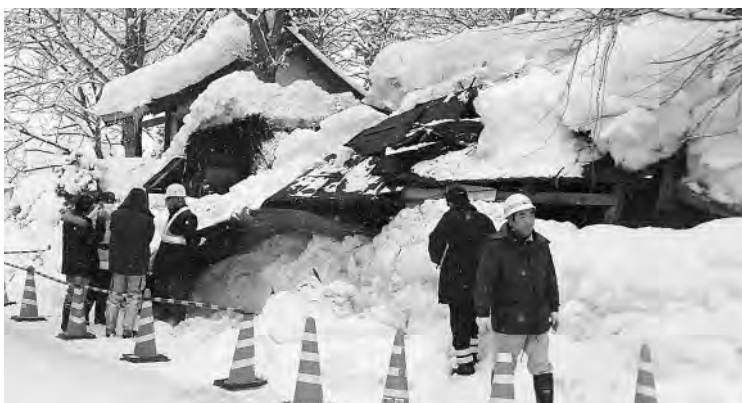
豪雪で倒壊した空き家
