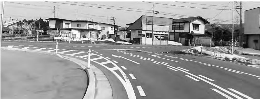
工事が予定される藤田大明神線
