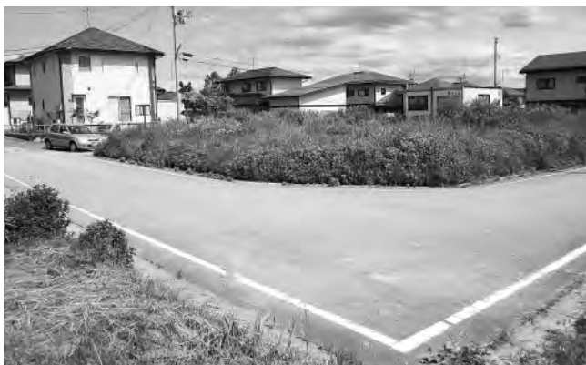
町道認定を受けた道路（蛍水地区）
