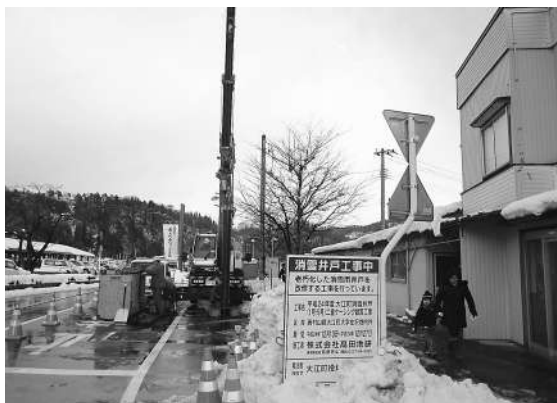
左沢駅前井戸ケーシング工事
