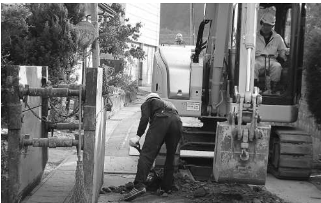
小見地区下水道延伸工事
