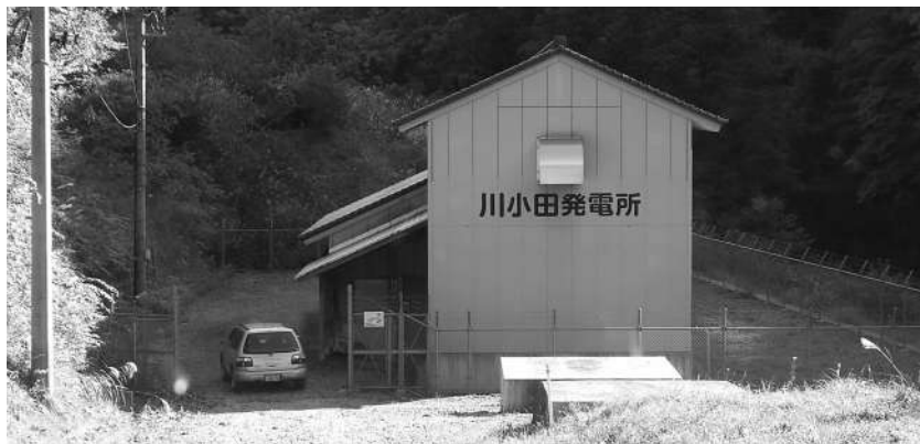
北広島町の川小田小水力発電所
