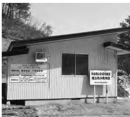
寒河江市幸生地区にある大平最終処分場
