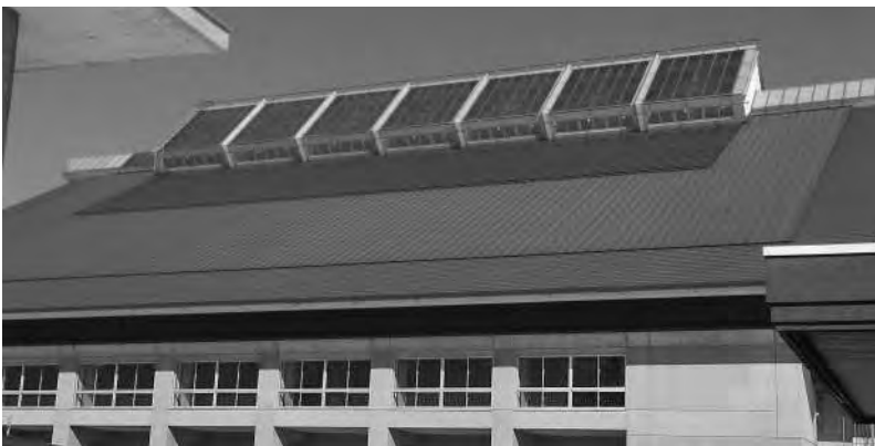
避難所への太陽光発電設備の設置が望まれる体育センター
