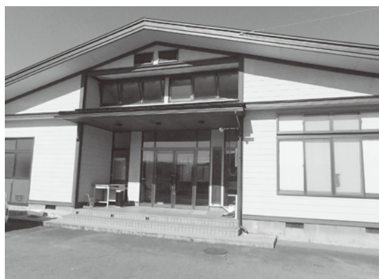
水洗トイレに改修される諏訪原公民館
