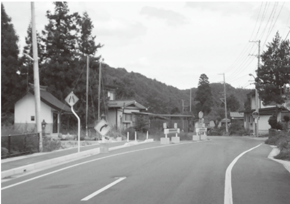
三合田地区の未整備区間
