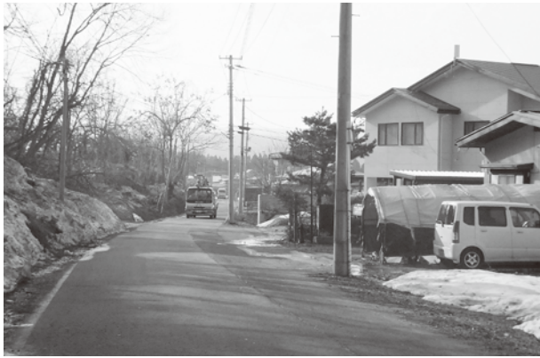
広く整備される藤田堂屋敷線
