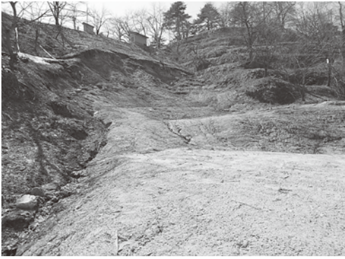
左沢楯山城跡復旧工事
