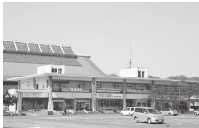
秋に解体予定の中央公民館
