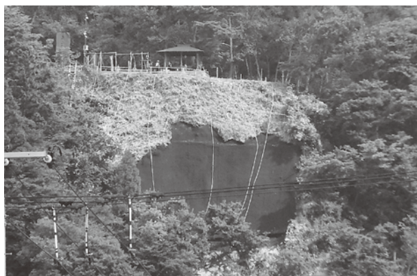
楯山公園南側表面のがけ崩れ
