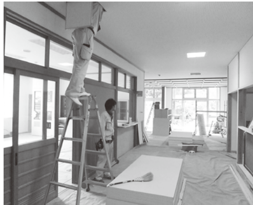
旧七軒西小学校の改修状況
