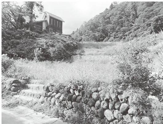
解体された被災住宅跡
