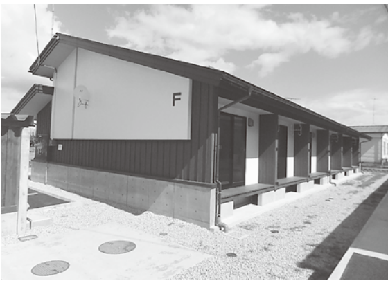
完成し入居者を待つF棟
