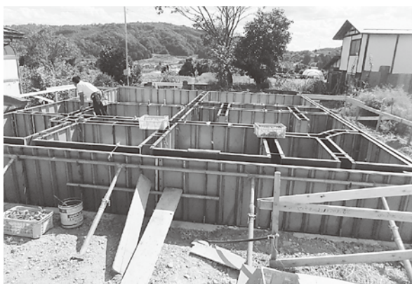
急ピッチで建設中の新規就農者用住宅
