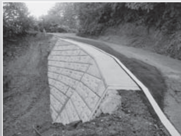
大頭森線災害復旧工事
