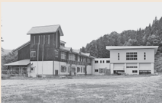
宿泊施設への改修工事をおこなっている旧七軒西小学校
