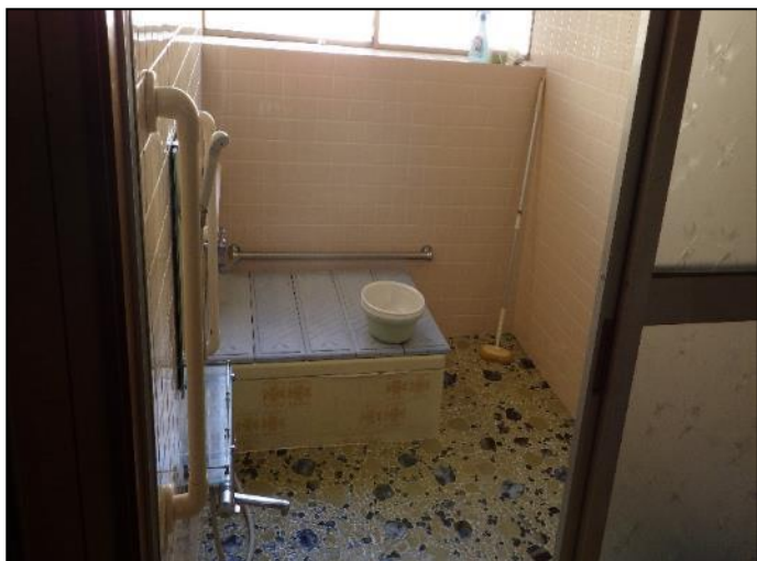
⑥浴室（増改築部分）
