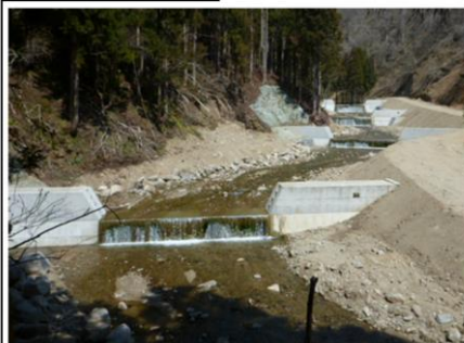
溪床の安定化を図る治山ダム
