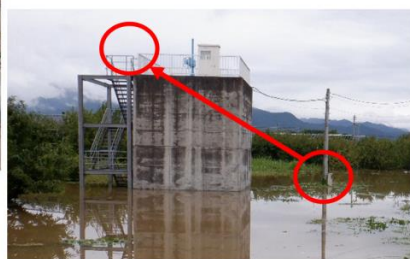
浸水のおそれのある 受電盤の移設
