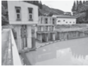
取水堰…寒河江川をせき止め原水を取水する
