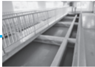
フロック形成池…ゆっくりかき混ぜ大きな泥の粒を作っていく
