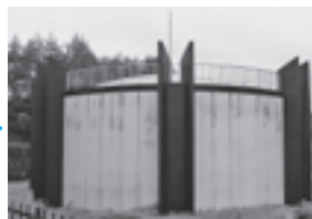
送水管を通して楯山配水池へ給水
