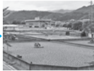
西川浄水場…導水トンネルを通り西川浄水場へ
