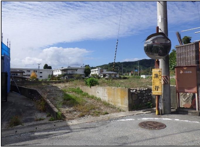
道路から敷地入口
