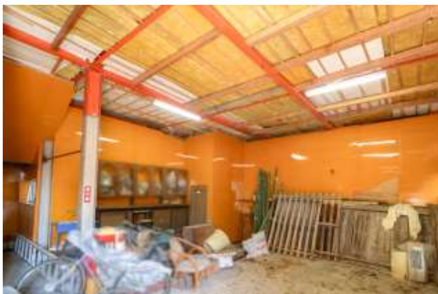
↑天井は鉄骨むき出しです。
