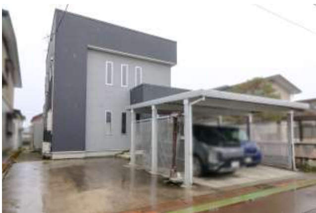
↑公道側。二台分のカーポートがあります。
