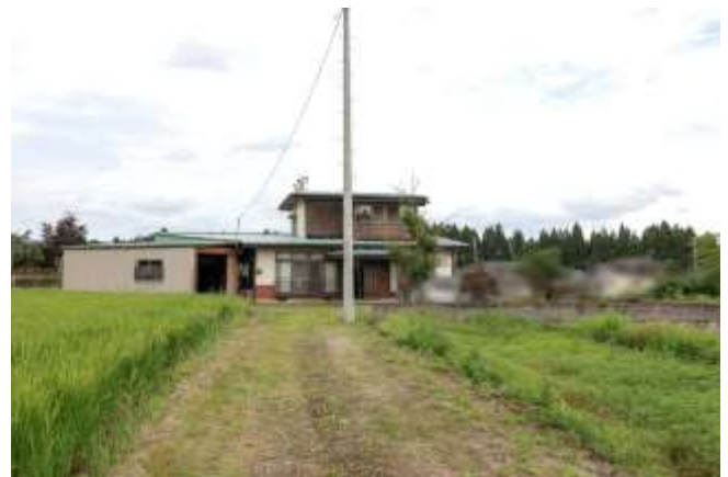
↑ 公道側から。※私道の除雪は自力で行います。
