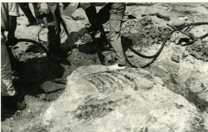
削岩機による化石周辺岩盤の掘削（1978年8月30日）
