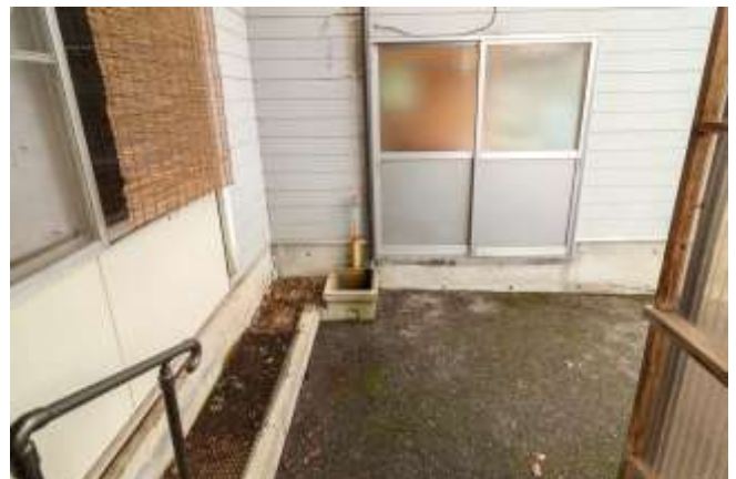
↑ガレージ横には水道蛇口があります。
