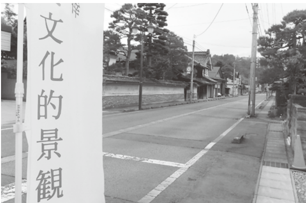
赤錆が見られる原町の道路
