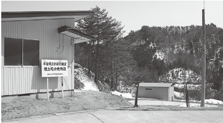
寒河江市幸生にある大平最終処分場
