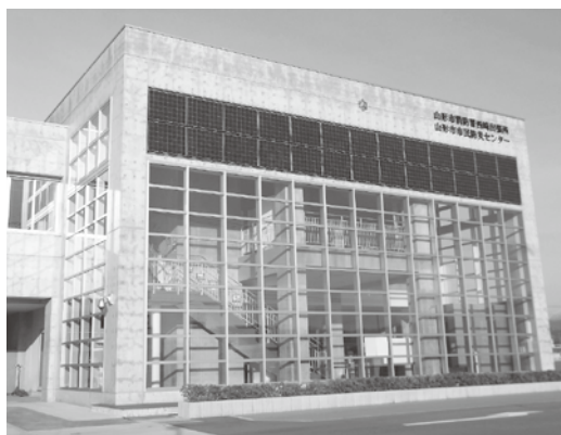
垂直パネルを設置した山形市市民防災センター
