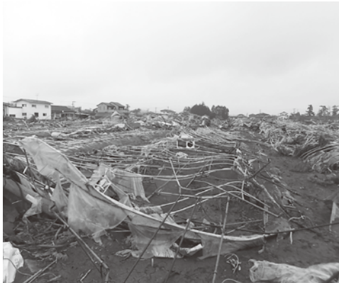
当時のいちごハウスの被害状況
