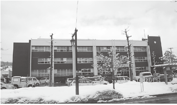
庁舎正面に設置される太陽光パネル
