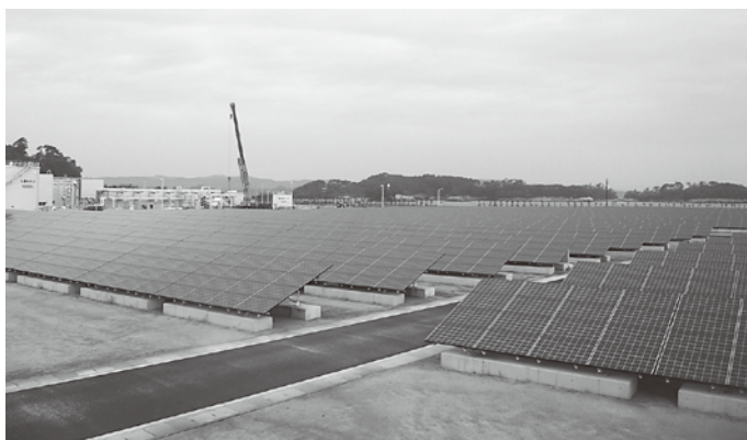
仙台太陽光発電所
