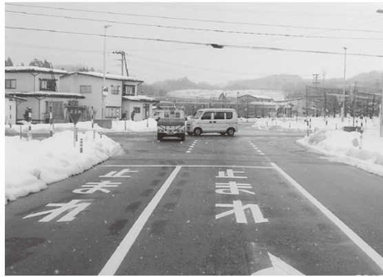
信号機を早急に設置してほしい(藤田地区)
