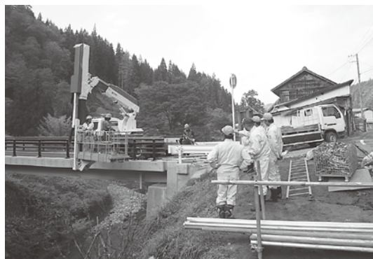
滝ノ沢橋 総工費 1,646万円 平成25年10月31日完成
