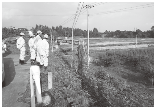
荻野 果樹園 1ha 応急本工事9月30日完了 排土量 1,410m 3 (ラフランス・もも・りんご) 田 4.14ha 復旧工事は平成26年度春の予定
