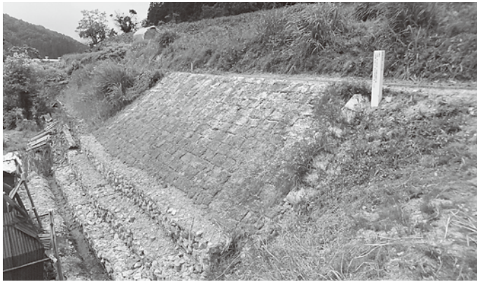
災害復旧工事が終了した月布堰の土手
