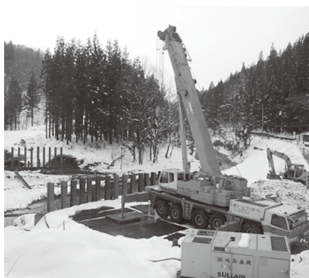
県道大江西川線貫見工区の様況
