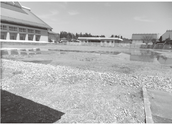
新しく建設される中央公民館解体現場
