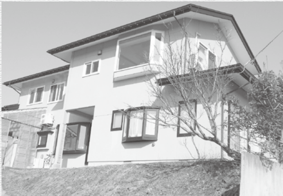
合併処理浄化槽が設置される新築住宅
