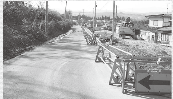
道路改良が進捗中の町道藤田堂屋敷線
