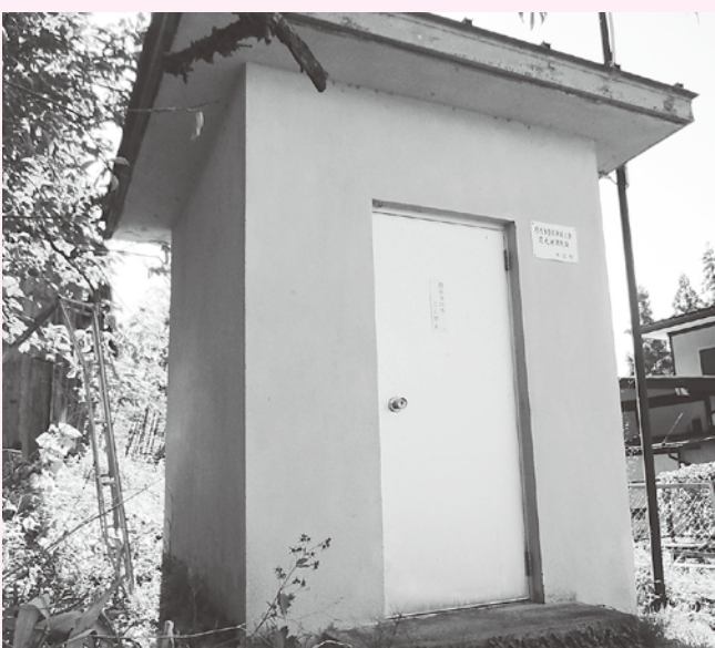
用 簡易水道施設
