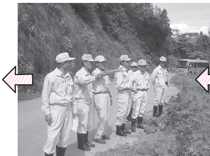
荻野堰取水口工事現場 (鵜の淵橋付近にて)
