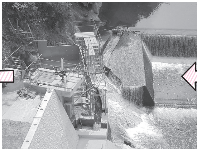
月布川から取水する荻野堰工事現場
