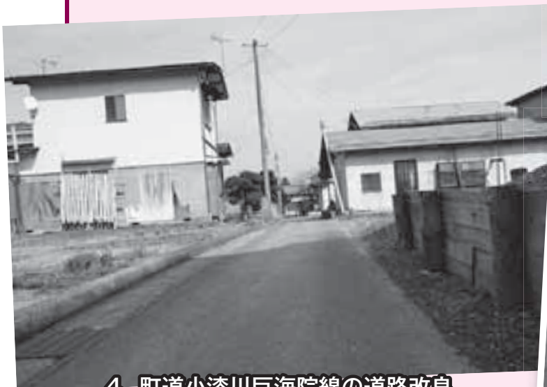
4. 町道小漆川巨海院線の道路改良
