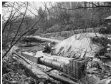
工事中の小見ため池
