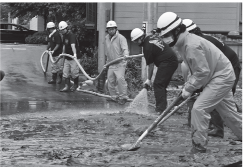
消防団員による泥撤去作業
