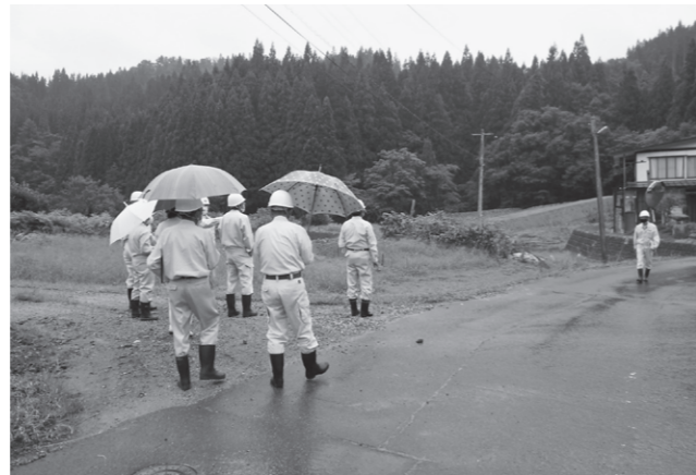
貫見の土砂流出現場
