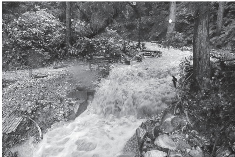
被災した檜山地区の南堰
