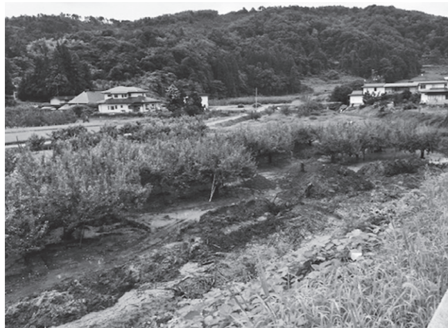
荻野 被災現場
