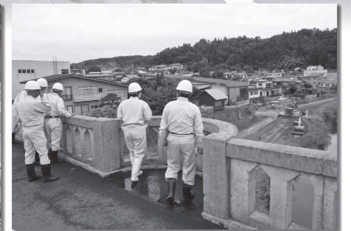
百目木地区の災害現場
