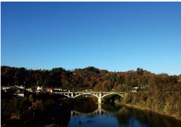
旧最上橋（最上橋（新最上橋）から）
