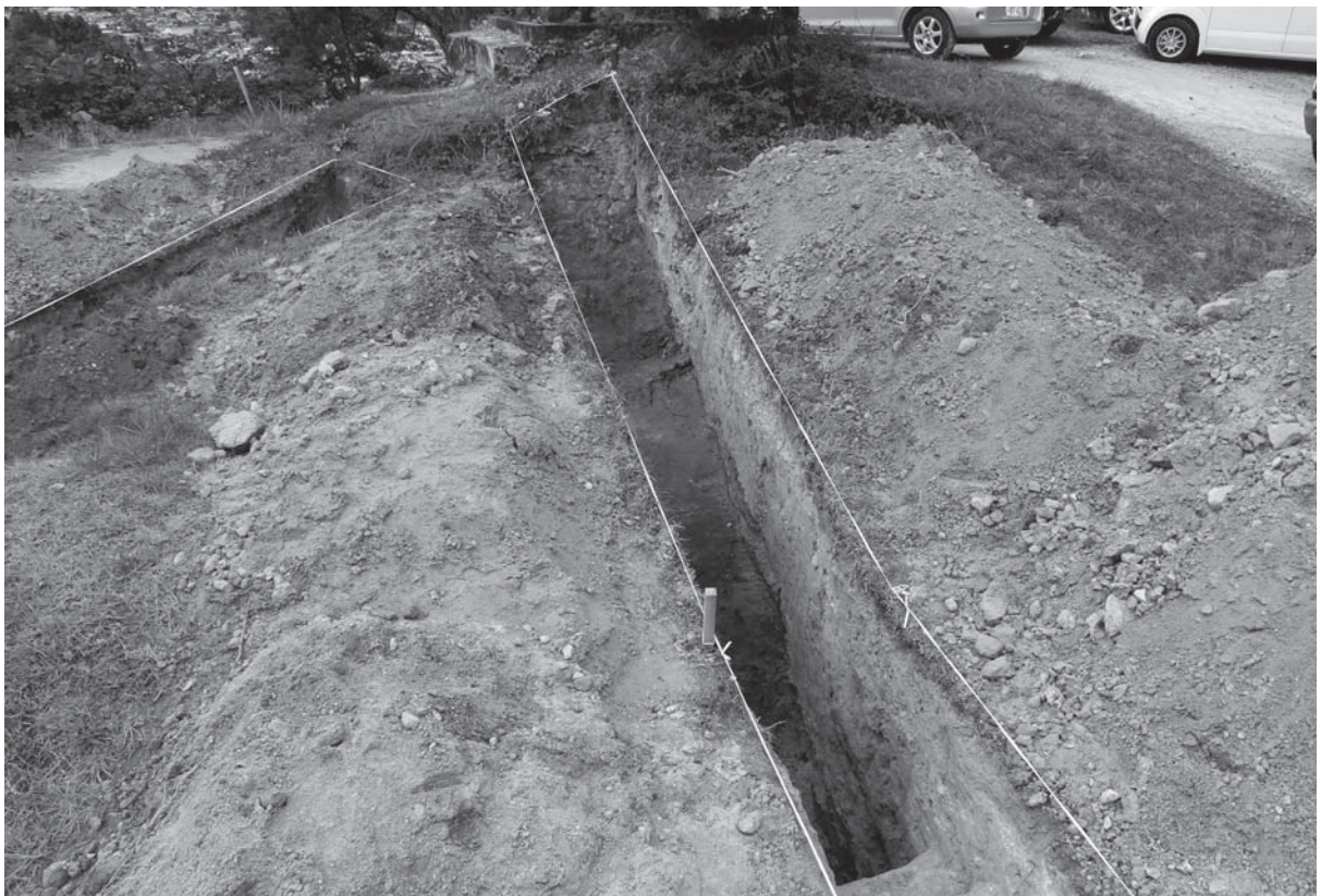
八幡平地区楯山公園 B4 6TS (北東から)
