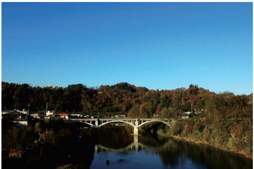
旧最上橋 (最上橋(新最上橋)から)
