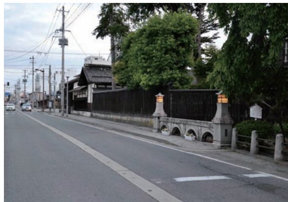
町中の水路に架けられた橋
