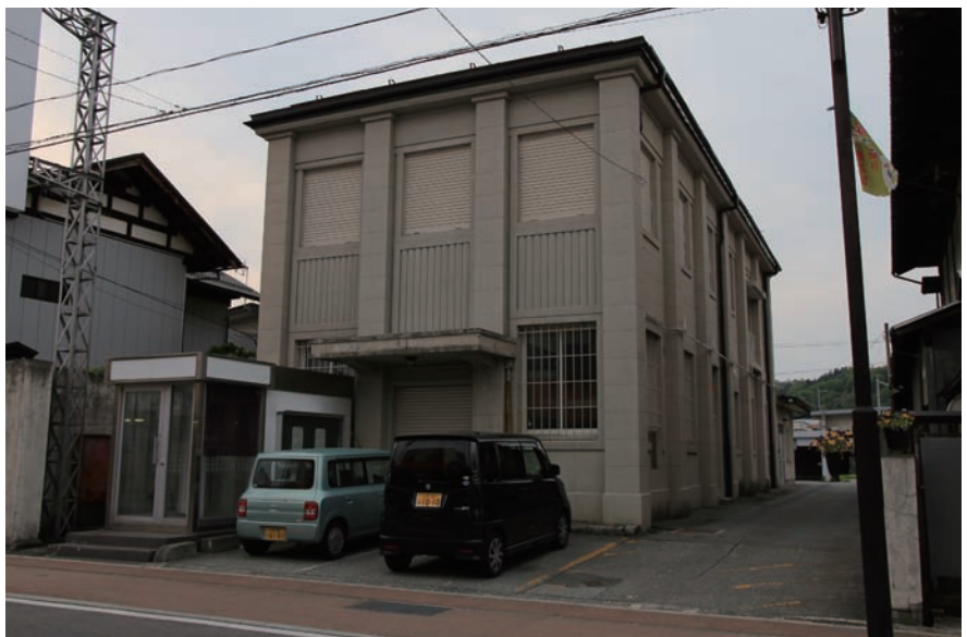
鉄筋コンクリート造りの銀行 (昭和 11 年大火後建築)
