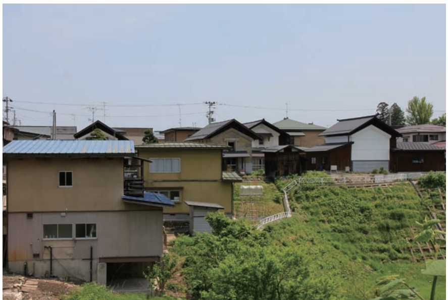
敷地の奥に並ぶ土蔵（御免町：裏から）
