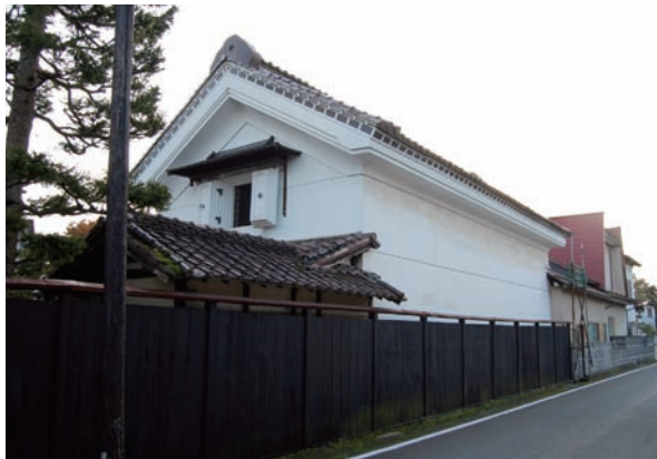
店舗・住宅の裏にある土蔵（御免町）
