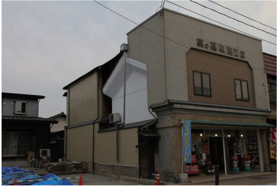
店蔵（改装あり）・土蔵を保有する例（内町）
