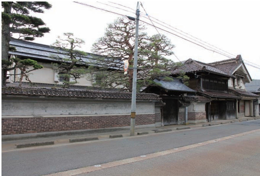
店・店蔵・主屋・座敷蔵等を網羅的に保有する例 (原町)
