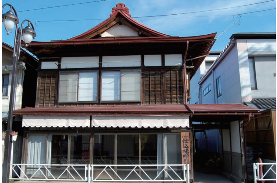
妻入商店建築の二階屋根に入母屋造りを採用した例 2 (原町)
