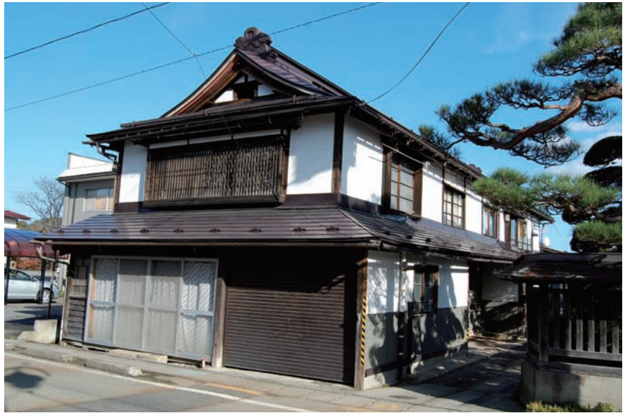
妻入商店建築の二階屋根に入母屋造りを採用した例 1 (原町)
