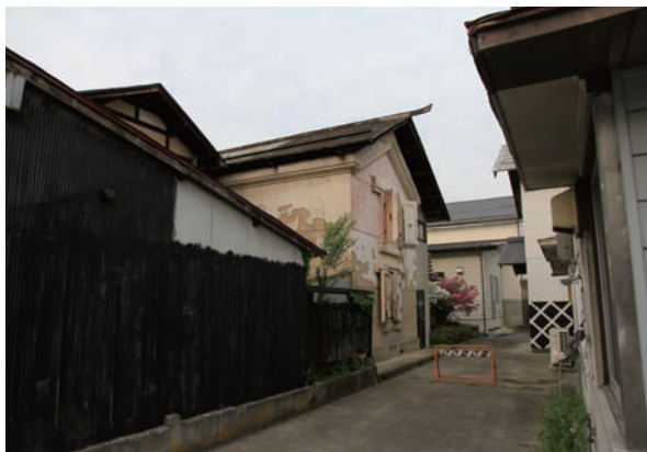
商店建築・住宅の裏にある土蔵（横町）
