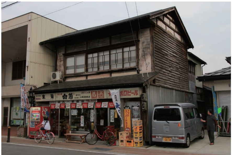
複数の仕上げが混在する建築の例 (内町・横町通り沿い)
