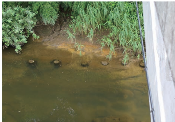
旧最上橋（木橋）の橋脚跡
