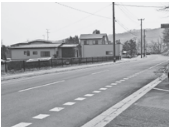
▲町道藤田堂屋敷線
