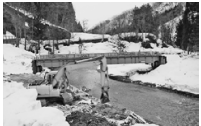
▲工事が始まった県道大江西川線（貫見側）
