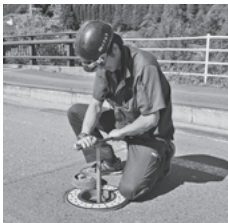
▲道路下に設置されている仕切弁と排水弁を操作
