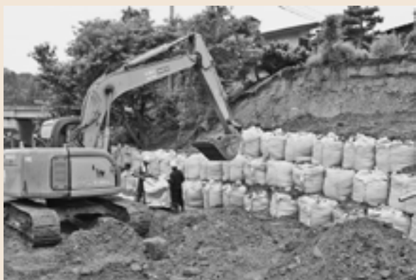
▲各地で進む豪雨災害からの復旧(顔好橋付近)
