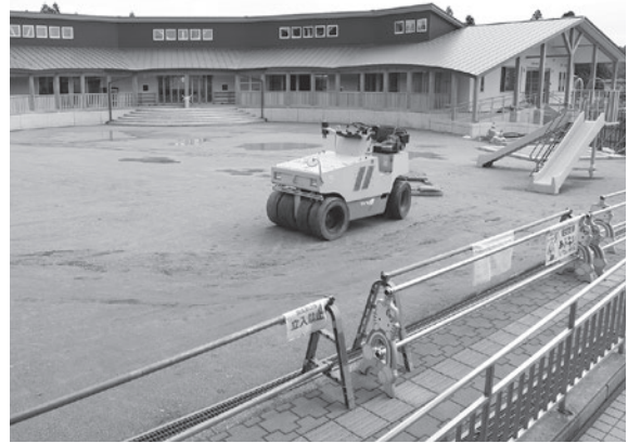
▲急ピッチで工事が進む町立保育園
