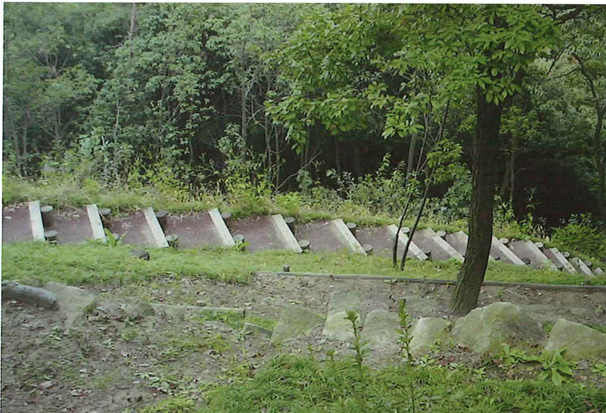
散策路設置例 5 金山城跡 (群馬県太田市) 路面は人工的な素材を使用
