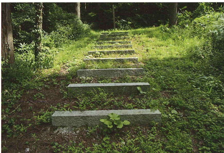
散策路設置例 2 延沢城跡 (山形県尾花沢市) 四角い石を設置、オフロードバイクなどの進入を防ぐ
