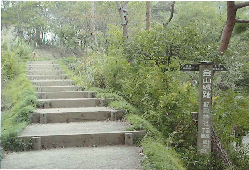
散策路設置例 4 金山城跡 (群馬県太田市) 木材による階段を設置
