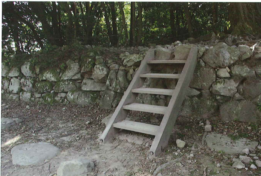
階段設置例 6 安土城跡 (滋賀県近江八幡市) 木製の階段を設置
