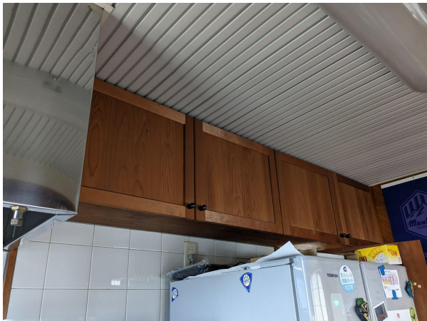
コンロ上部とシンク上部(キッチン側、ダイニング側)ともに収納スペースもありますよ。
